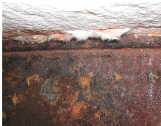
d) Brennkammerwand (innen)
